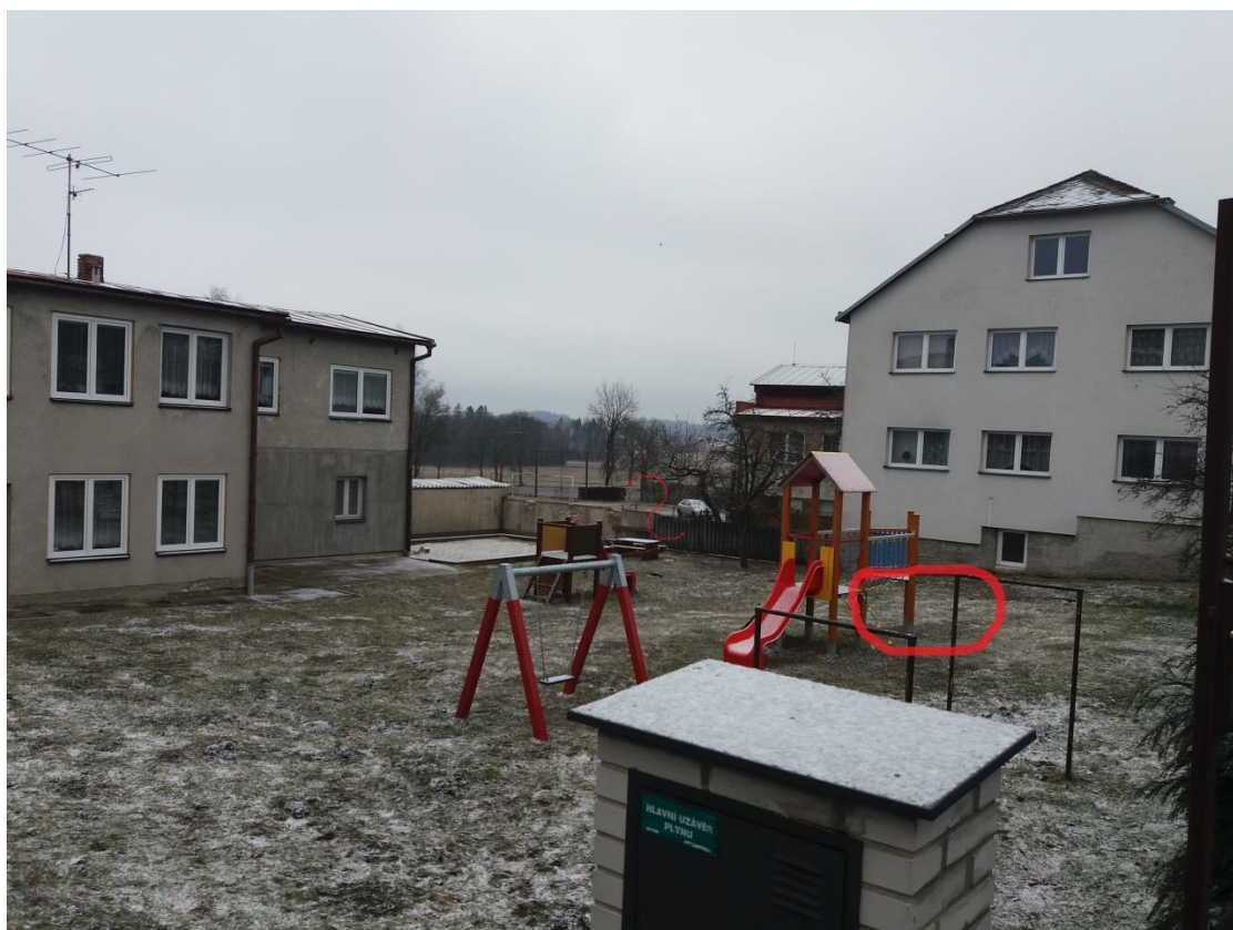
V únoru jsme měli poruchu na vodovodu před bytovkou, viz. označené místo. Foto FSz
